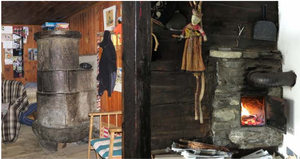
Le fourneau en pierre ollaire, côté chambre et côté cuisine, dans un des plus vieux chalet d'Eison
