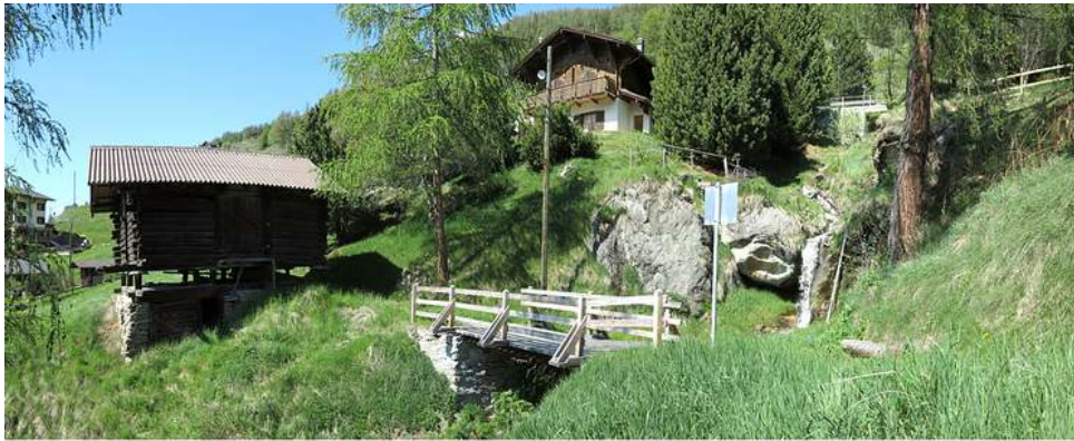
Le pont sur le torein do Melly, ancien chemin entre Eison et La Crettaz
