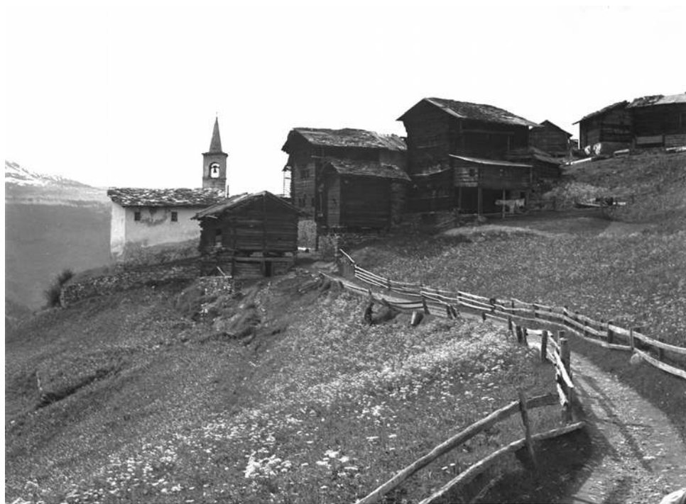
Le chemin quittant Eison en direction de La Crettaz
